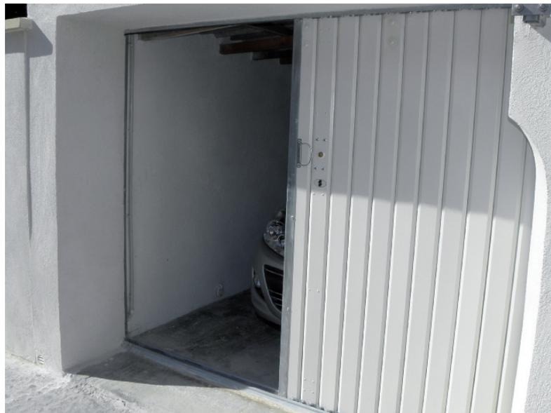
L'ensemble de la porte est suspendu par galets et guidé dans un rail supérieur et inférieur.
